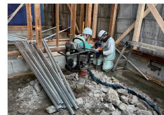
石神井川沿いの軟弱地盤の影響で建物が傾いていました。傾きを修正後、鋼管杭 (10kN / 本) を 55 本打込んだ上に、耐圧盤を設け基礎と一体化し、沈下対策を施しています。
